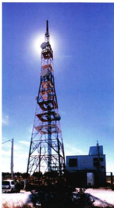
Figures 3 i 4: A baix, torre micrometeorològica FLUXPYR a Catalunya per a la medició en continu dels fluxos de carboni, aigua i energia entre el sòl i l’atmosfera, en una parcel·la agrícola: l’anemòmetre, analitza-dor infraroig de CO 2 i vapor d’aigua, pluviòmetre i radiòmetre són alguns dels instruments utilitzats. A l’esquerra, torre alta a la Muela mesurant en continu la concentració atmosfèrica de CO 2 i diverses variables meteorològiques (IC3)
